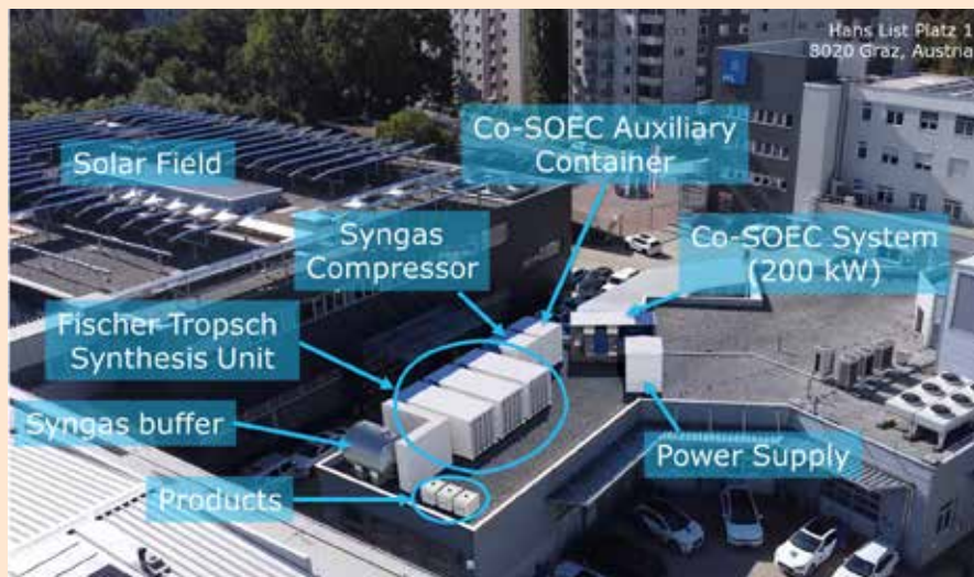
Die Bestandteile der Demo-Anlage (von links): Synthesegas-Puffer-tank, drei Fischer-Tropsch-Einheiten, zwei Synthesegas-Kompressoren und die Elektrolyse-Einheit.
